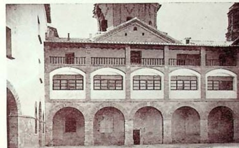
GALERÍA DE COMUNICACIÓN ENTRE LA PARTE DE EDIFICIO DEDICADA A ESCUELAS Y COLEGIO, Y LAS VIVIENDAS DE LOS PADRES.
