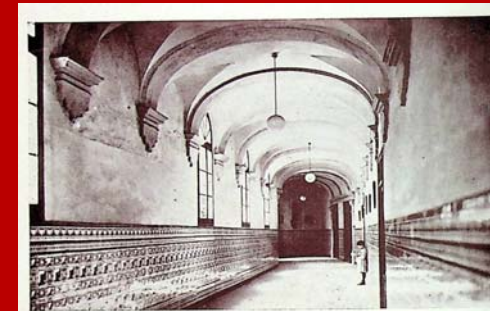
GALERÍA BAJA QUE DA ACCESO A LAS ESCUELAS PÚBLICAS DE LOS PP. ESCOLAPIOS, CUYO COLEGIO AÚN SE ENCUENTRA EN PERÍODO DE RECONSTRUCCIÓN.
